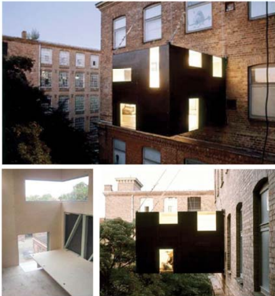
Fig 9. Rucksack House by Stephen Eberstadt.
